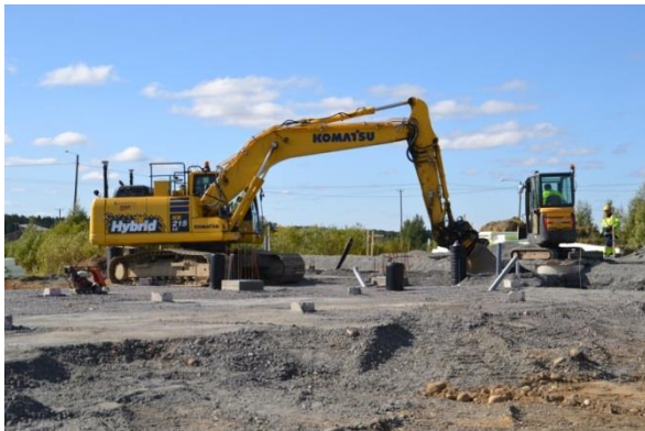
Kuva 1. Isoilla koneilla työ sujuu. Paalutus ja reilu murskepenkka takaavat, että laitoksen nurkat pysyvät suorassa.
