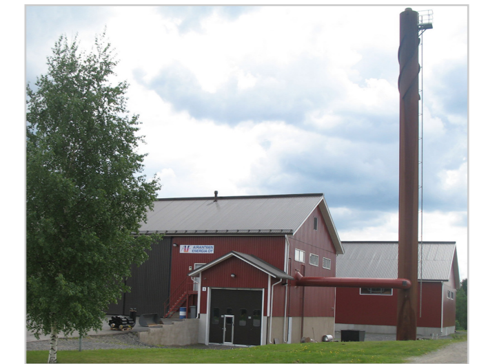
Airanteen Energia Oy:n 2,5 MW lämpölaite käyttää pääpolttoaineenaan metsähaketta.
